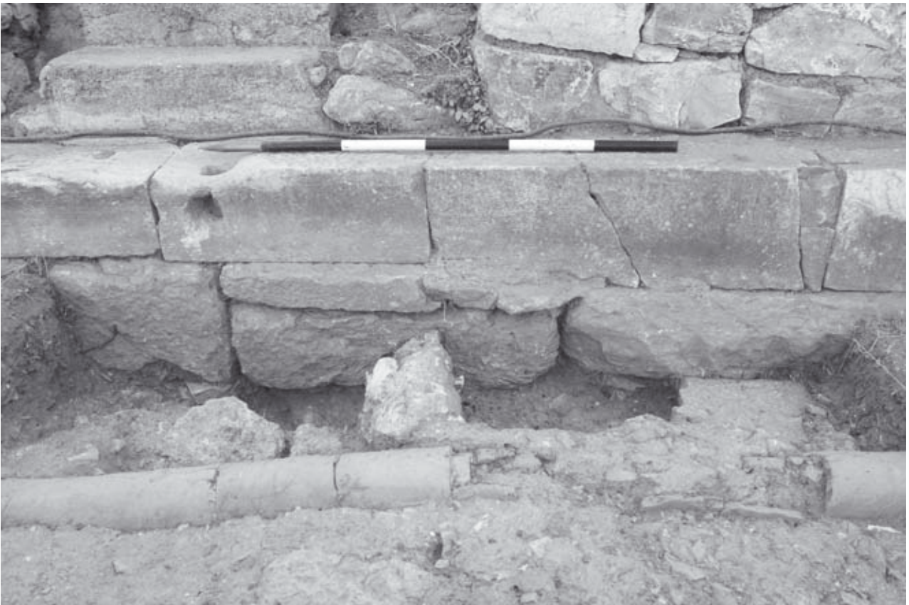
Abb. 235: Mittleres Diazoma, S 4/2008, Fundament u. Sockelzone der Diazomawand, von SW
