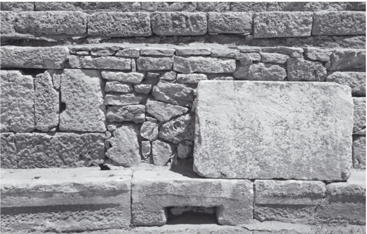
Abb. 222: Mittleres Diazoma, S 1/2008, Diazomawand mit Revisionsöffnung u. rezent aufgesetztem Orthostat
