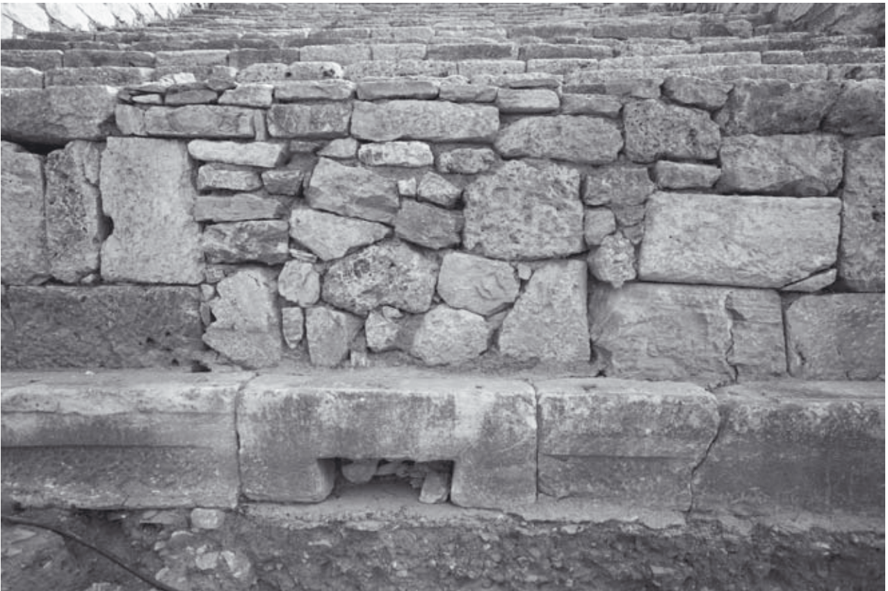
Abb. 223: Mittleres Diazoma, S 1/2008, Diazomawand mit Revisionsöffnung, Ansicht von W
