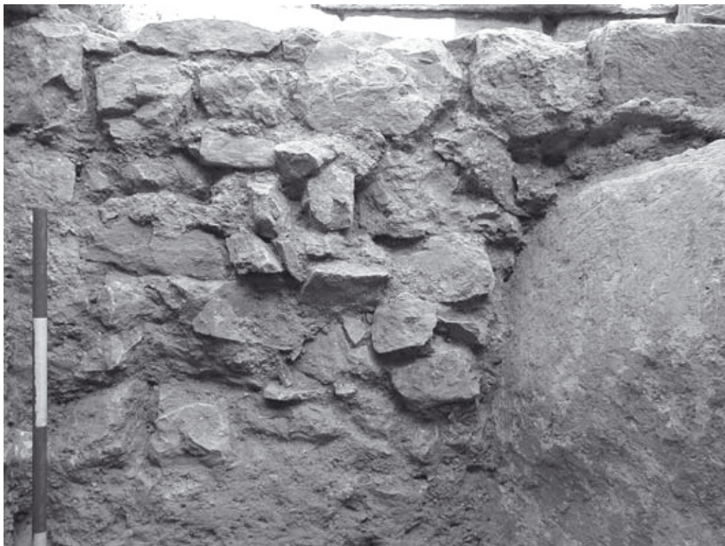
Abb. 116: Logeion, S 1/2002, Pfeilerfundament, W-Ansicht
