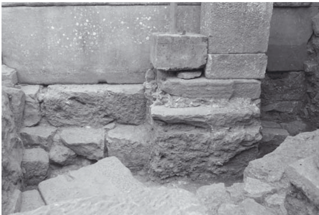
Abb. 142: Logeion, S 2/2003, Fundament unter der Parodosmauer Q von W
