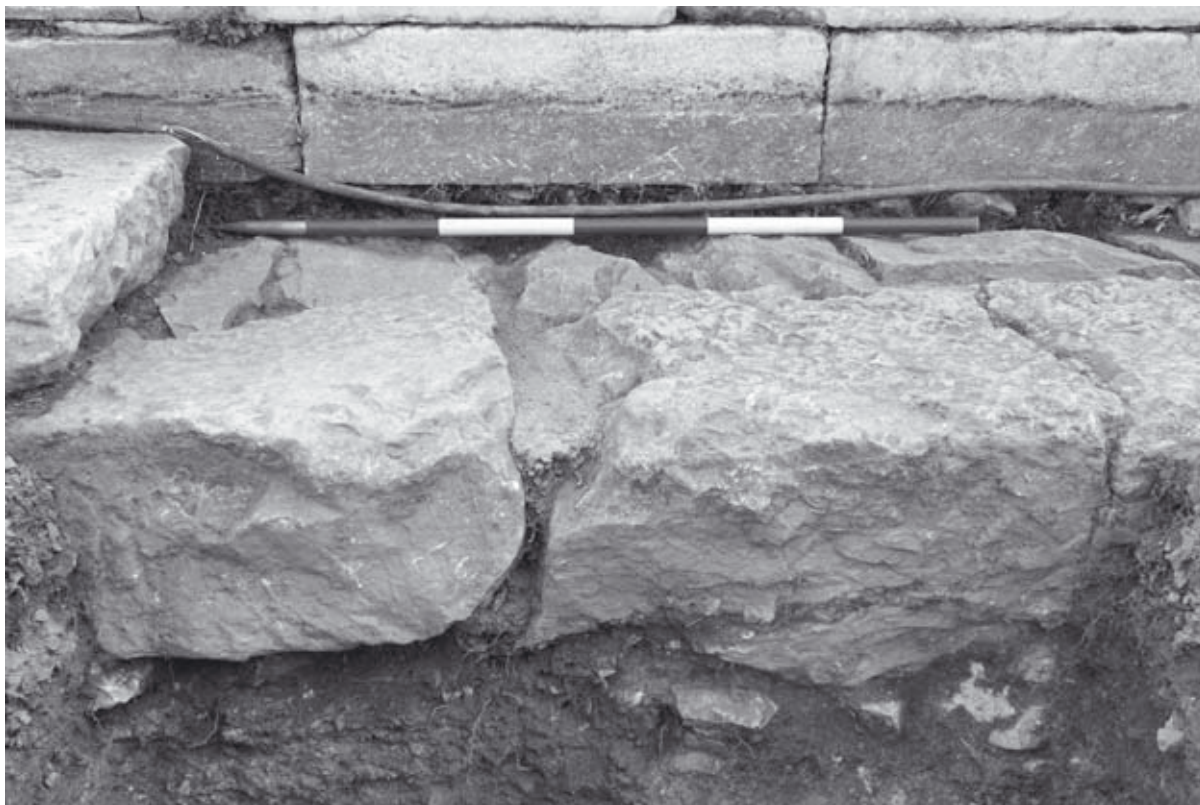
Abb. 190: Unteres Diazoma, S 3/2006, Fundament der Diazomawand, von W
