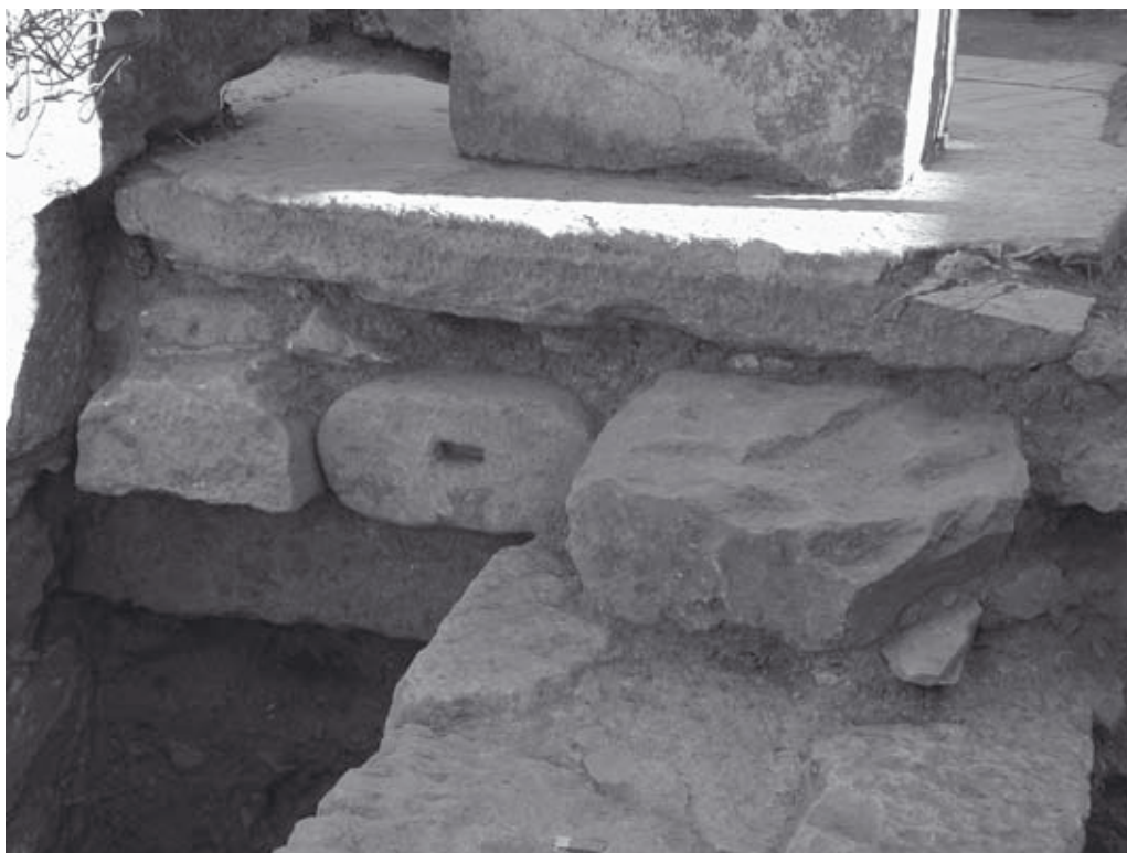
Abb. 117: Logeion, S 1/2002, »Binder« u. Platte unter Pfeiler H6
