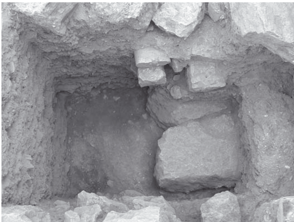
Abb. 121: Logeion, S 1/1969, Brekzieblöcke unter dem Streifenfundament, von N
